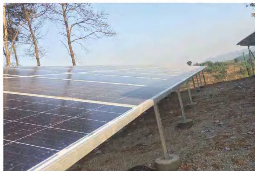
(涟源项目电站在夕阳的余晖中成为一道靓丽的风景)
