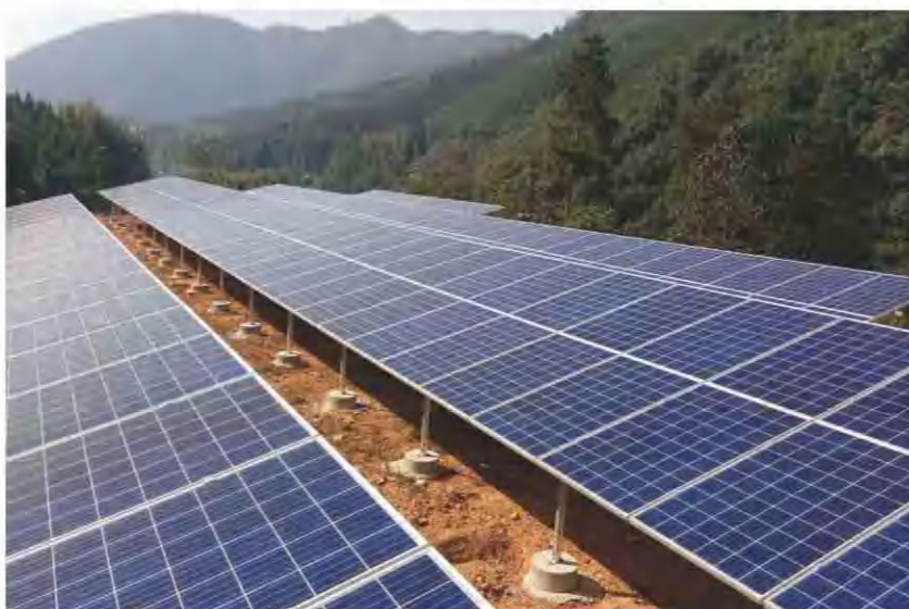
(祁阳项目慈源村整体已经全部完工，近期有待竣工验收)
