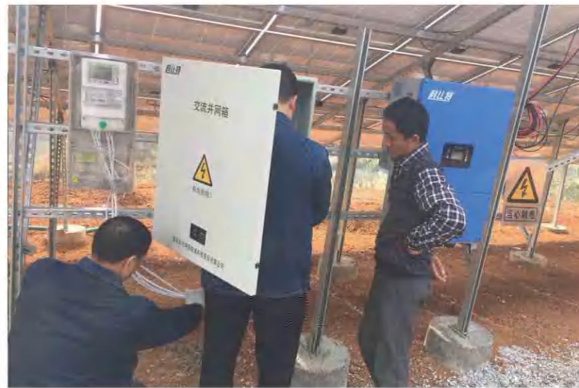
(施工员们正在认真仔细又熟练的安装逆变器配电箱)
